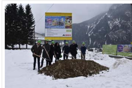
Zwar kühles, aber bestes Bauwetter: Am Donnerstagnachmittag fand der offizielle Spatenstich für das Explorer Hotel Umhausen statt. Foto: Paschinger
